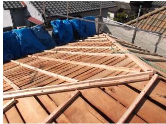
瓦と葺き土の撤去後、屋根地調整を行います
