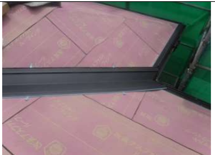
谷部分には専用の谷板を取り付けます
