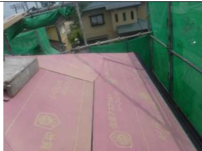
防水下地材を取り付けます
