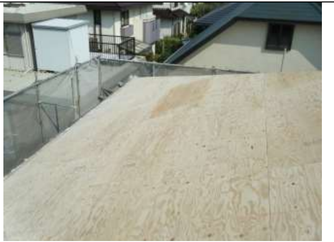
構造用合板（コンパネ12mm）を取り付けます
