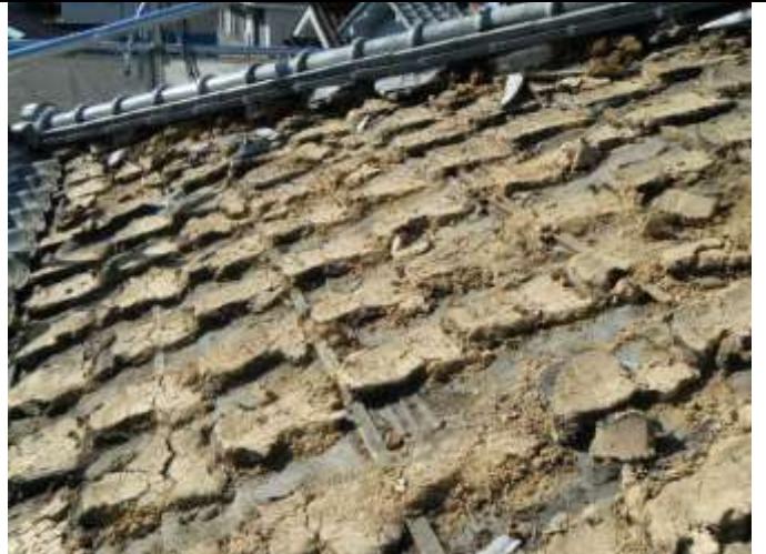
瓦と葺き土を取り除きます
